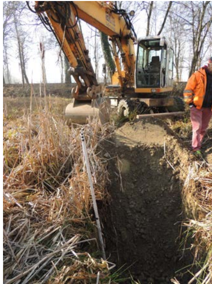
Dettaglio pozzetto esplorativo
