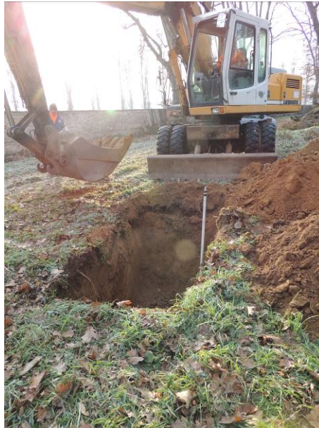
Dettaglio pozzetto esplorativo
